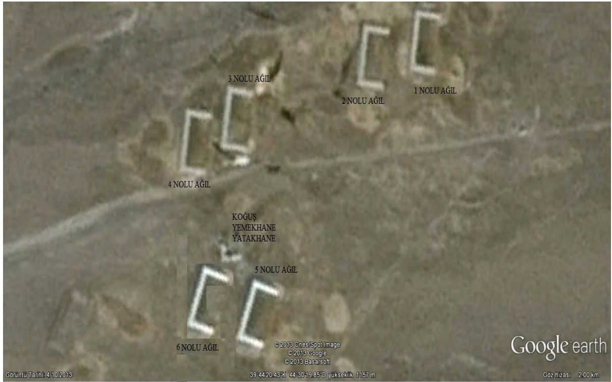
Şekil 7. Karakayalar bölgesindeki U tipi bina ve tesisler
