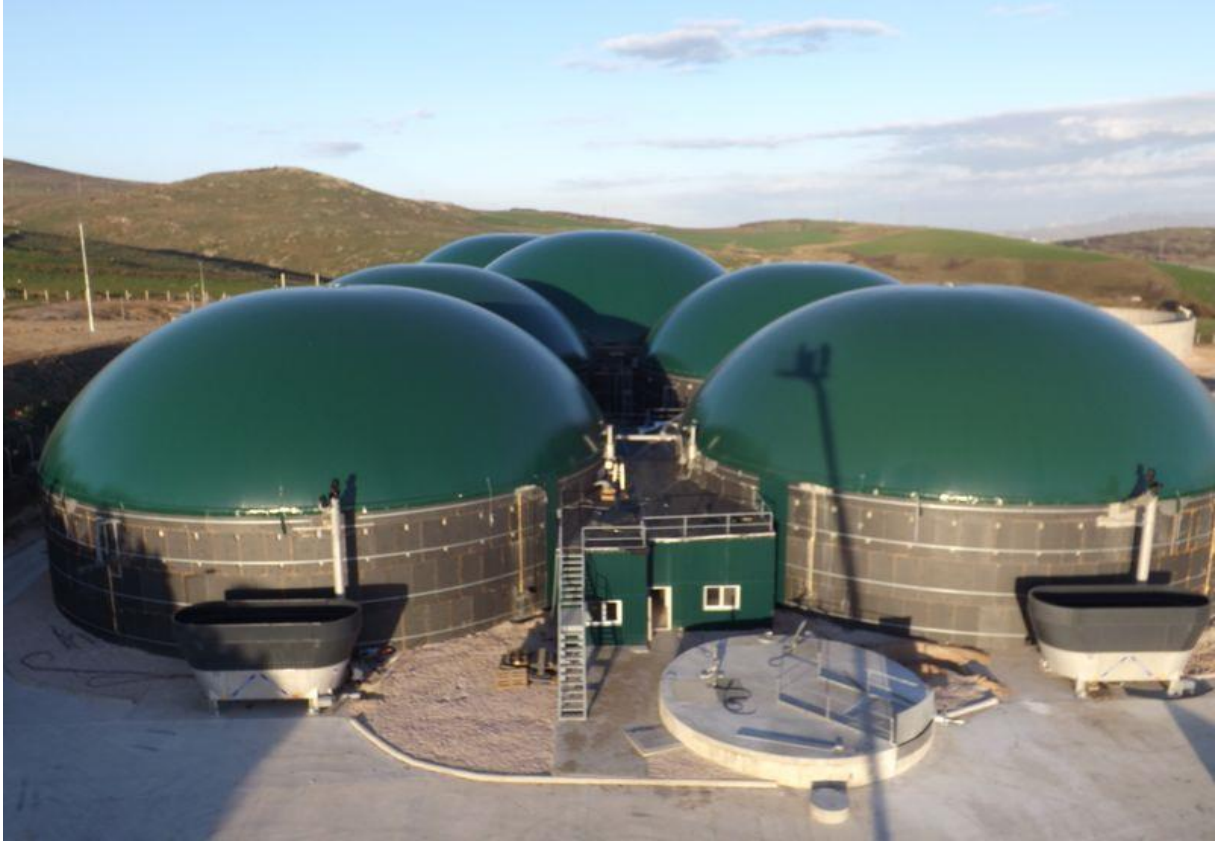
Resim 6. 2,2 MW Kapasiteli Biyogaz Tesisi-2
