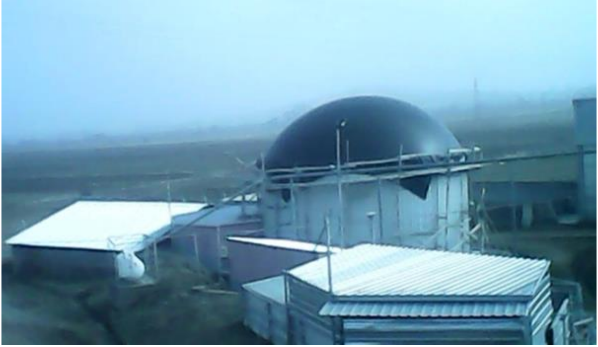
Resim 9. 100 kW Kapasiteli Biyogaz Tesisi-2
