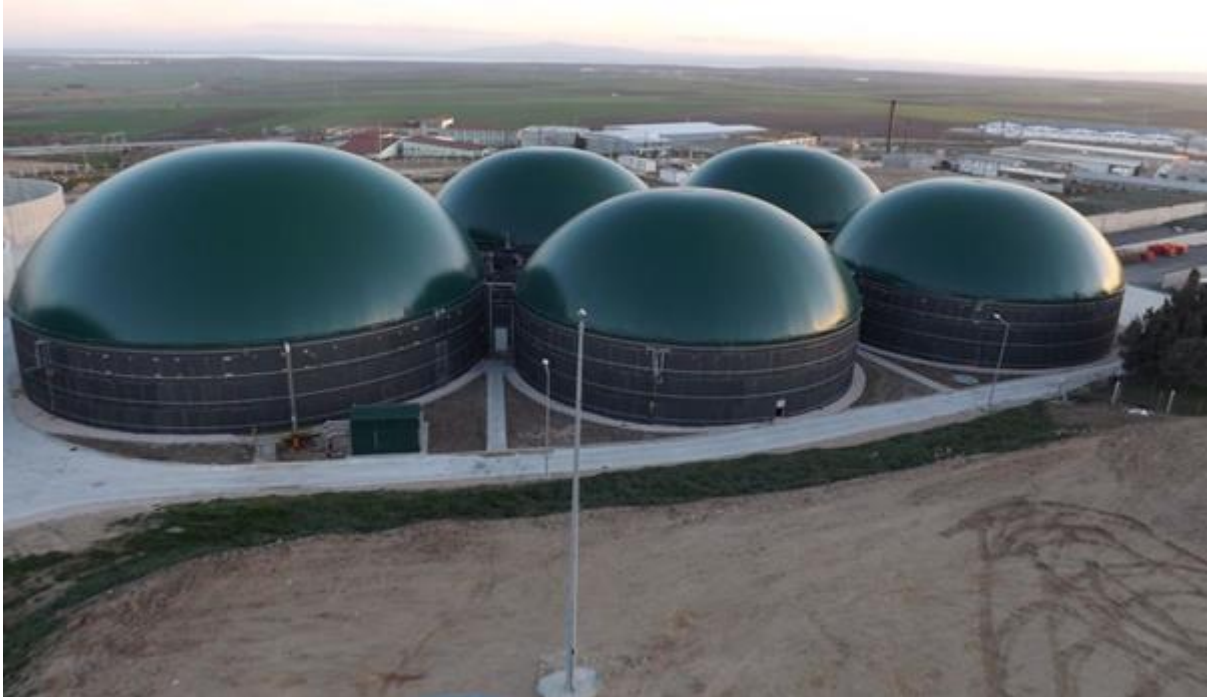
Resim 7. 2,2 MW Kapasiteli Biyogaz Tesisi-3
