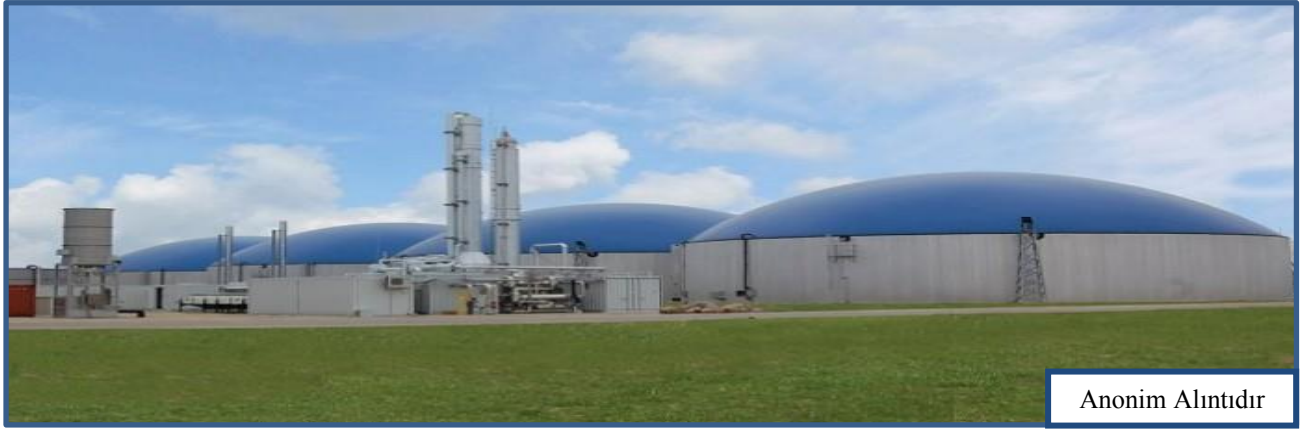
Şekil 20. Balon Tipi Biyogaz Tesisi
