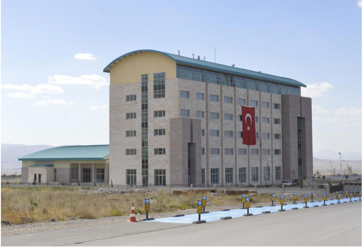
Resim 1: DAP Bölge Kalkınma İdaresi Hizmet Binası
