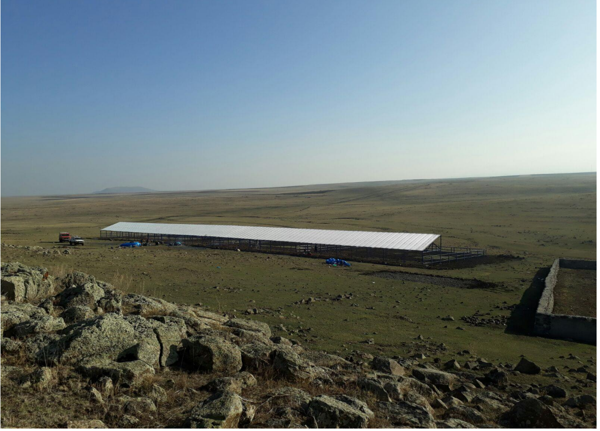
Resim 18: Mera Altyapısının İyileştirilmesi Projesi-Merkez Karakaş Köyü (Kars)
