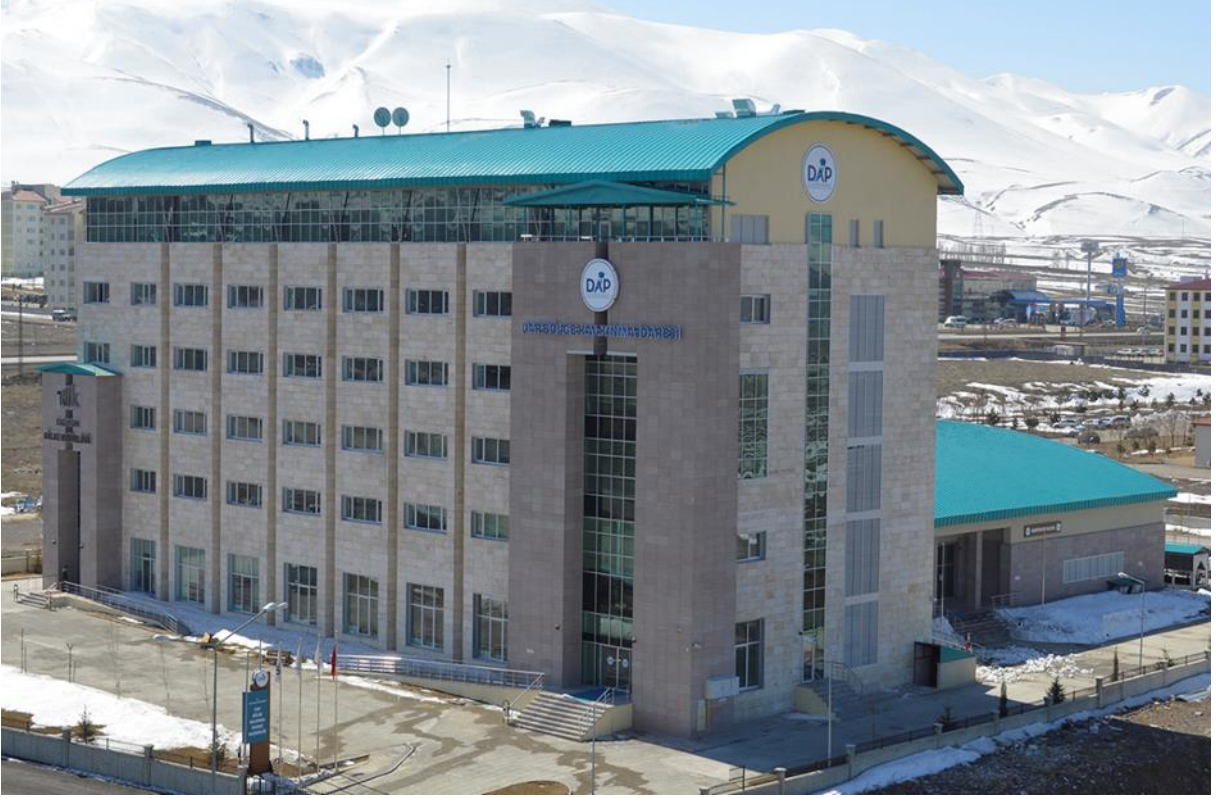
Resim 1: DAP Bölge Kalkınma İdaresi Hizmet Binası
