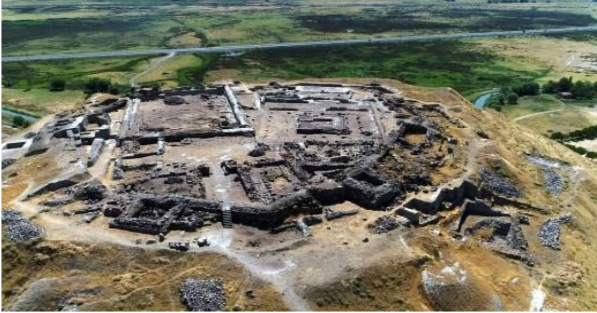
Resim 13: Altın-tepe Kalesi Restorasyonu Projesi (Erzincan)
