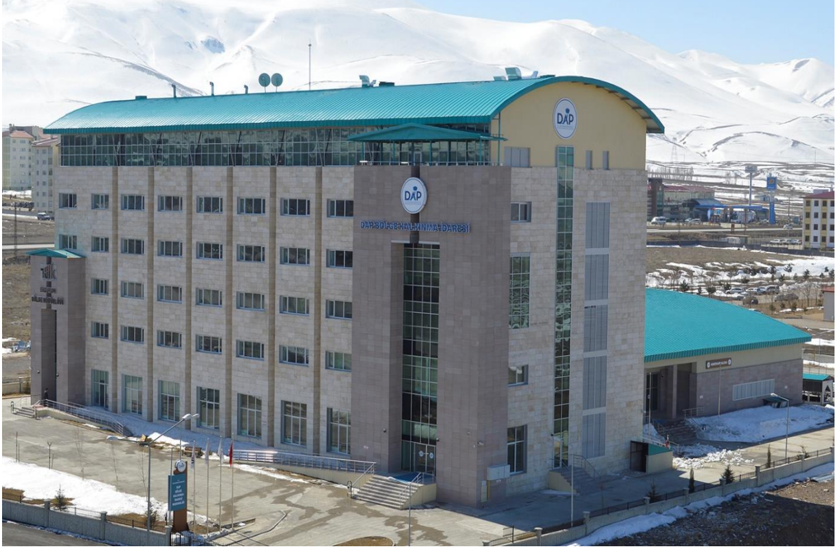
Resim 1: DAP Bölge Kalkınma İdaresi Hizmet Binası
