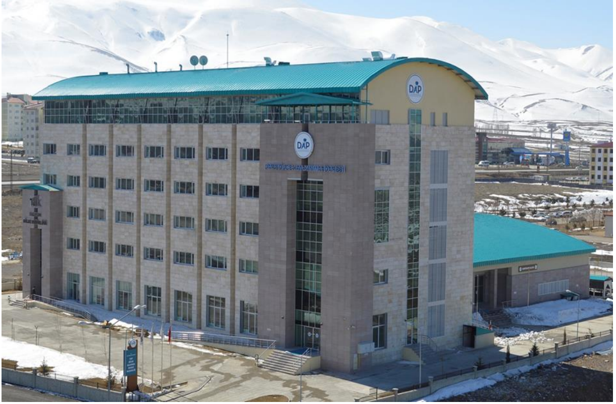
Resim 1: DAP Bölge Kalkınma İdaresi Hizmet Binası
