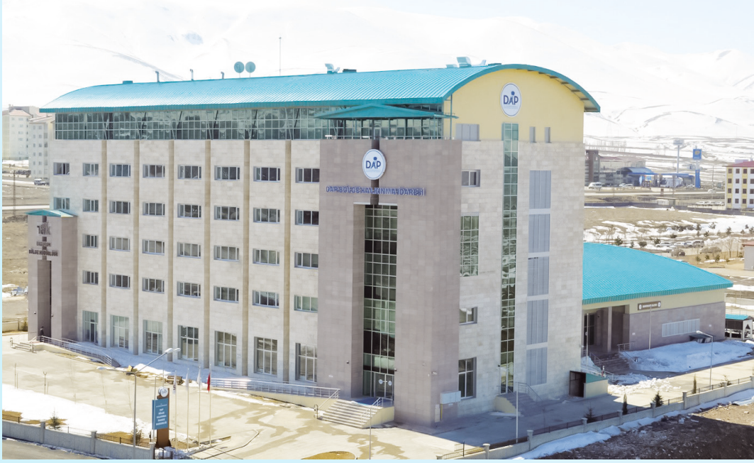
DAP İdaresi Hizmet Binası
